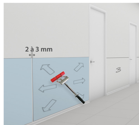
Maroufflez vers l'extérieur à l'aide d'un rouleau marouffleur en partant du centre de la plaque
